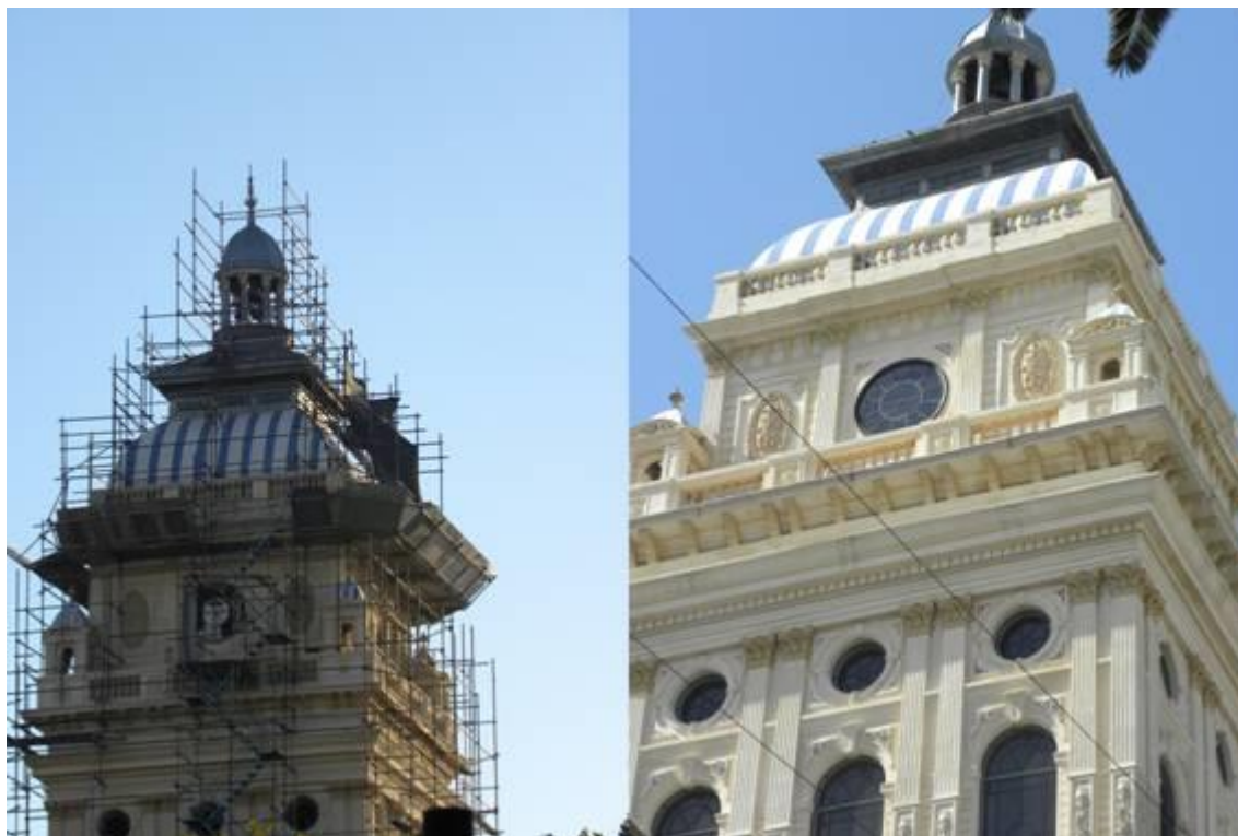
Figura 11. Torre en restauración 2010-2011.
